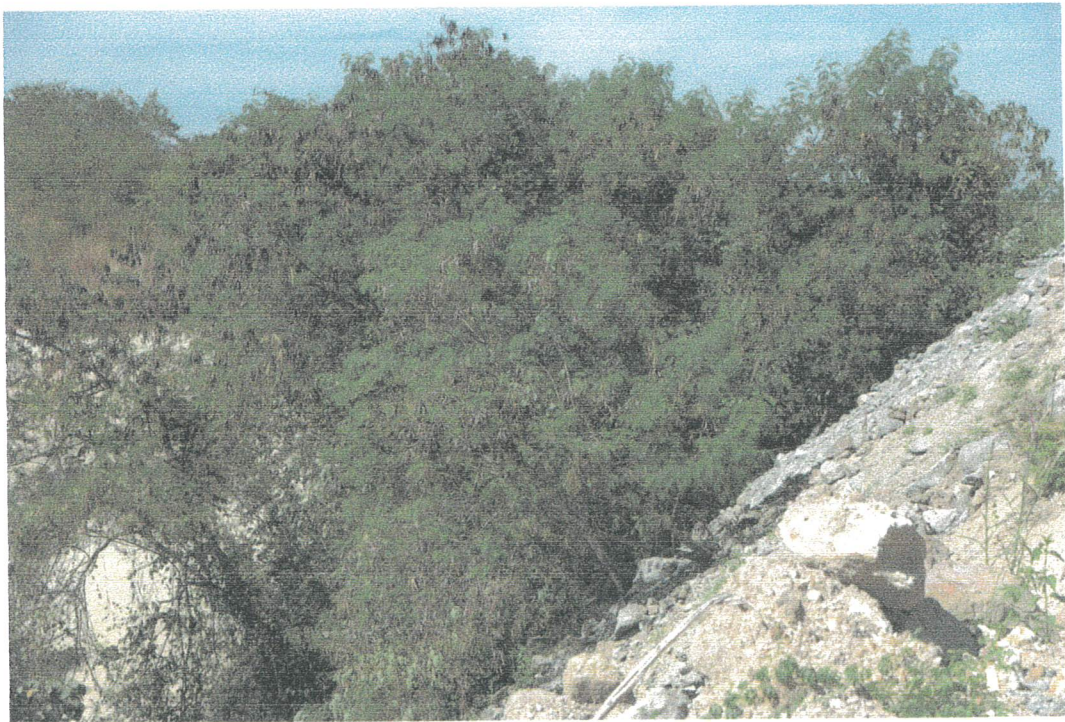
รูปที่ 5 การปลูกพืชคลุมดินบริเวณกองเปลือกดินด้านที่ไม่มีการเคลื่อนไหวน้ำไม่ให้เกิดการพังทลาย
